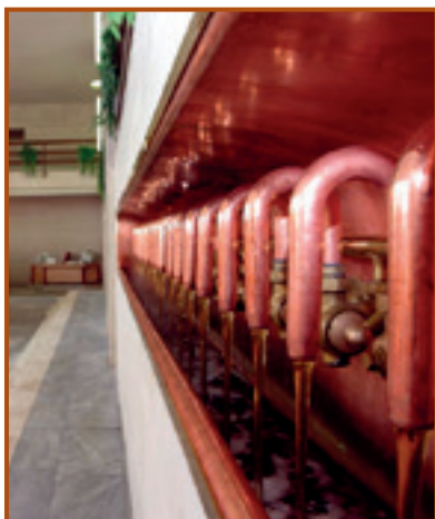
6 Význam decentralní energetiky roste a potravinářské firmy mají možnost si vyrobit energie samy. Snadné to však není
