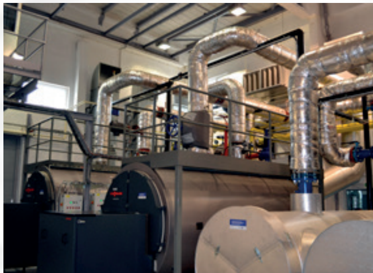
Kogenerační jednotka je moderním ekologickým zařízením, které dosahuje téměř 90% účinnosti ve využití primárního paliva
