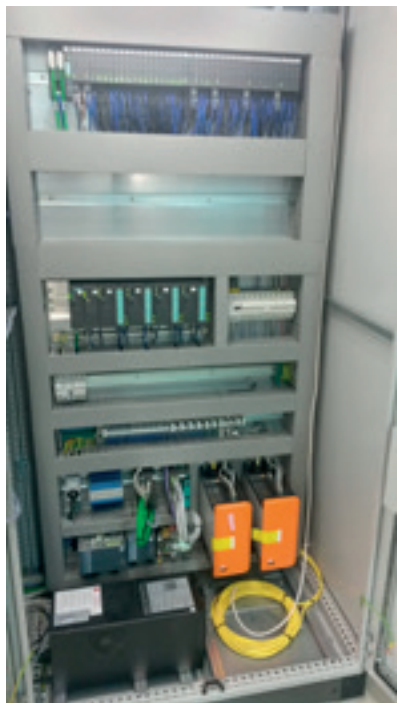
Obr. 1: Rozváděč řídicího systému surovinového hospodářství
