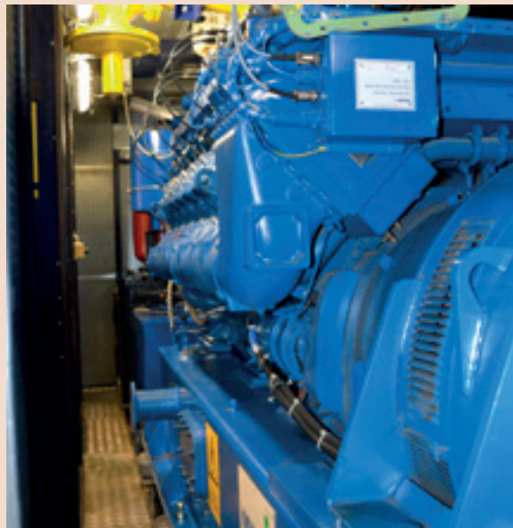
Motor kogenerační jednotky
