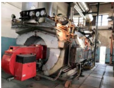
Obr. 6: Starý parní kotel na výrobu přehřáté páry s nízkou účinností
