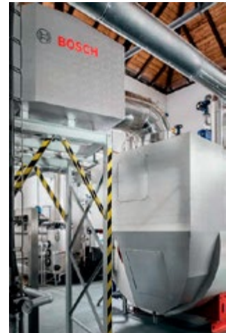
Obr. 3: Spalinový kondenzační výměník ECO6 pro ohřev užitkové vody a zvýšení účinnosti zařízení
