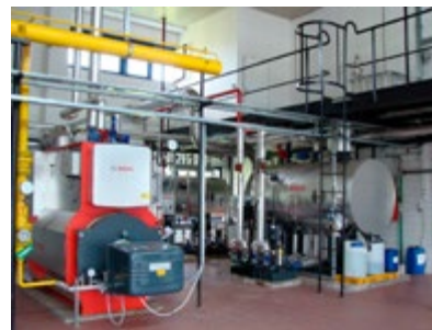
Obr. 8: Parní kotel UNIVERSAL U-MB 1650x13
