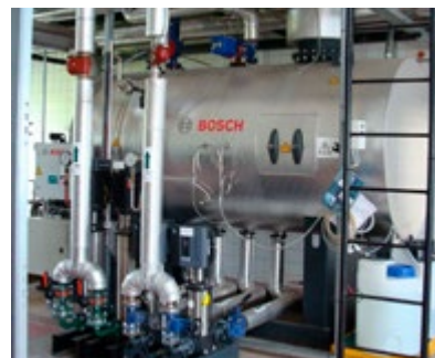
Obr. 9: Modul napájecí nádrže WSM-V vč. čerpadlových modulů PM
