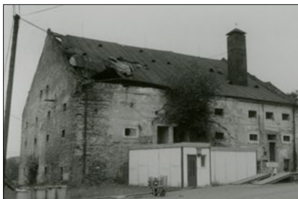
▲ Fotografie Pavla Jákla z roku 1988 zachycuje původní renesanční pivovar na Hukvaldech, který byl adaptován ryze sladovnickým účelům. Jednolískový vzdušný hvozdu byl osazen dřevěným párníkem, což je z požárního hlediska velmi atypické. Komín se dodnes nedochoval a památkově chráněná budova je v havarijním stavu.
