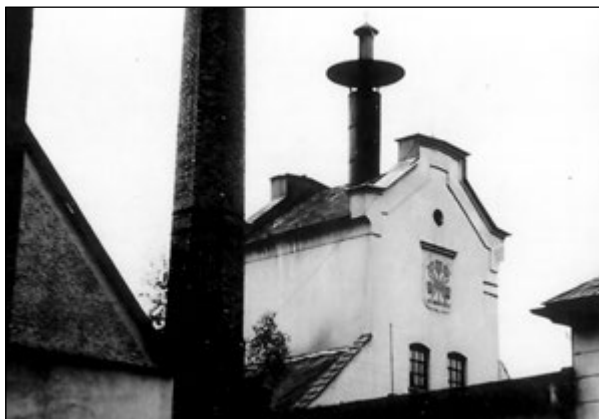
▲ Další slepou uličkou při výstavbě sladovnických hvozdu byly ocelové párníky, které projektoval Gustav Noback pouze v roce 1867, v dalších letech se na jeho plánech již neobjevují. Dodnes se žádná realizace nedochovala, ale z plánové dokumentace známe realizace v panském pivovaru v Kamenici nad Lipou, Konopišti, Roudnici nad Labem a Semilech. Na snímku Michala Jánského z roku 1978 je právě semilský hvozď před snesením párníku. Objekty se dochovaly dodnes.
