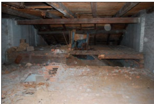
▲ Na fotografii z roku 2010 je zachycena provalená klenebná kopule nad lískou hukvaldské sladovny, kde byl ještě zřetelný dřevěný párník s vnitřním oplechováním. Při opravě střechy byla nadstřešní část párníku odstraněna.
