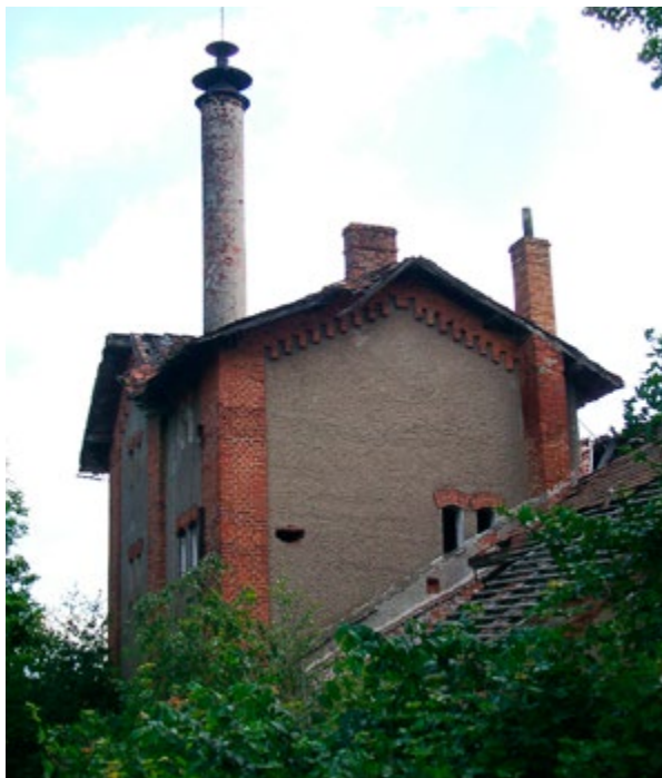
▲ Hvozďy systému Ječmen potřebovaly daleko větší tah než klasické dvojlískové hvozďy a proto byly osazovány vysokými komíny. Na snímku typický vysoký komín v jihočeské Plavnici. Technologie bohužel nebyla dochována a možná už ani stavba nestojí.
