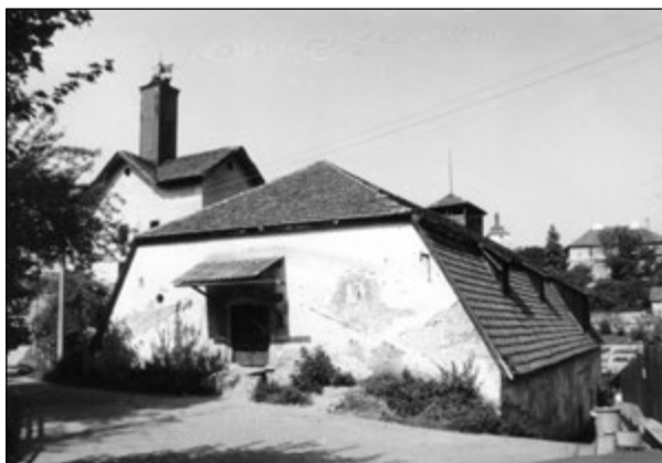
▲ Na fotografii Pavla Jákla z roku 1985 je zachycen pivovar v Jílovém u Prahy jako druhá známá realizace dřevěného párníku sladovnického hvozdu. Dřevěný párník čtvercového průřezu byl dokonce opatřen hydroizolačními asfaltovými pásy tzv. ipou, což možnost požárů velmi zvyšovalo. Uvnitř samotného hvozdu dokonce nebyla ani cihelná kopule nad lískami, ale výdřeva. Současný bezpečnostní technik by zaplesal. Jílovský pivovar byl zásadně přestavěn na obytné zařízení.
